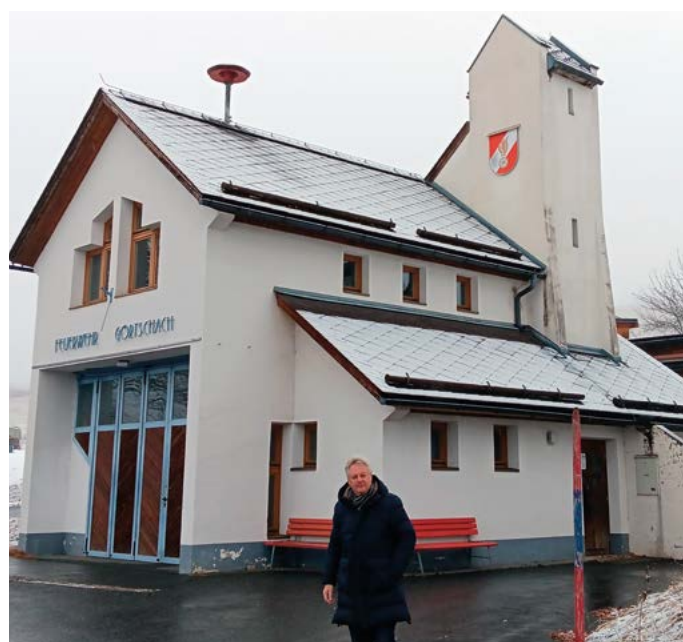
Das Dach des Feuerwehrhauses in Görtschach soll 2026 saniert werden.
