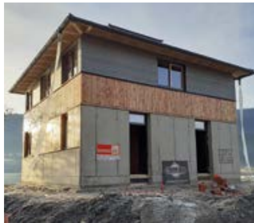
Neues Sanitärgebäude im Strandbad Hermagor.
