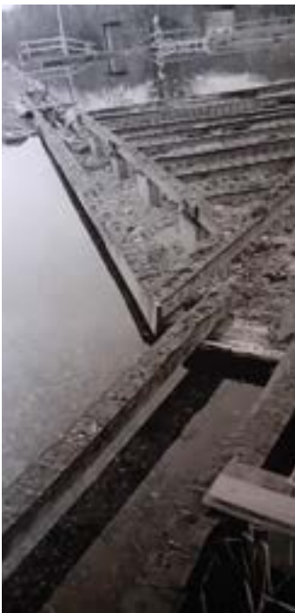
Naturschwimmbad Radnig – Erneuerung Badesteg
