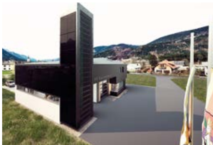
Rattendorf Neubau FF Haus
