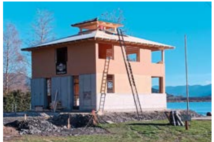
Der Rohbau des neuen Sanitärgebäudes ist fertig.
