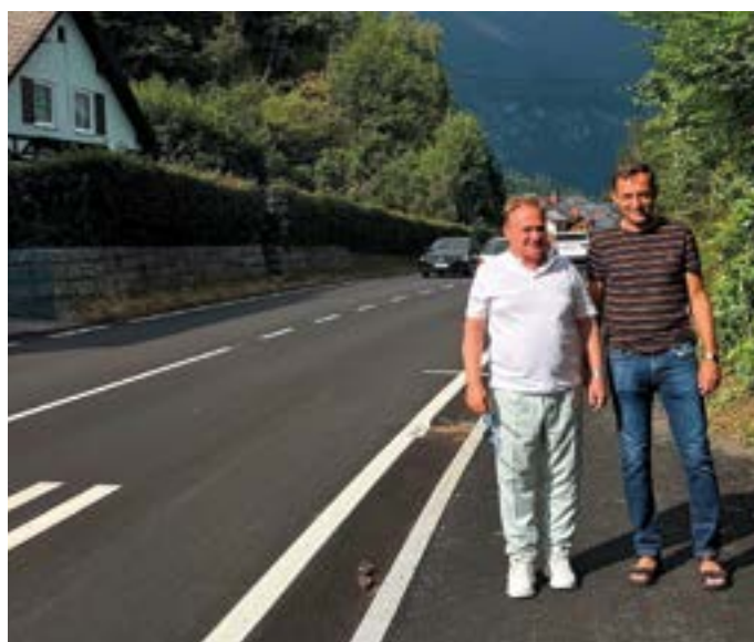
B 111 Gailtalstraße im Bereich Kriegerdenkmal.
