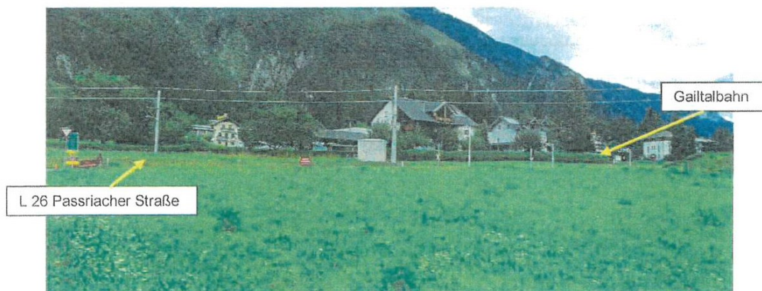
Ansicht der Widmungsfläche aus Südwesten (Foto: Wolschner)
